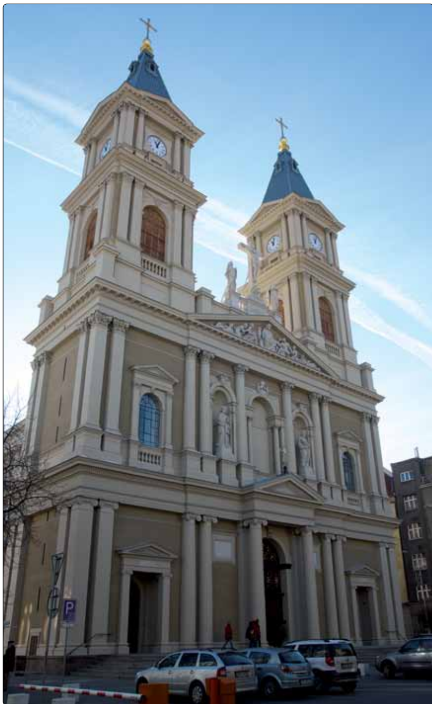
Katedrála Božského Spasitele v Moravské Ostravě po rozsáhlé rekonstrukci (22. listopadu)
