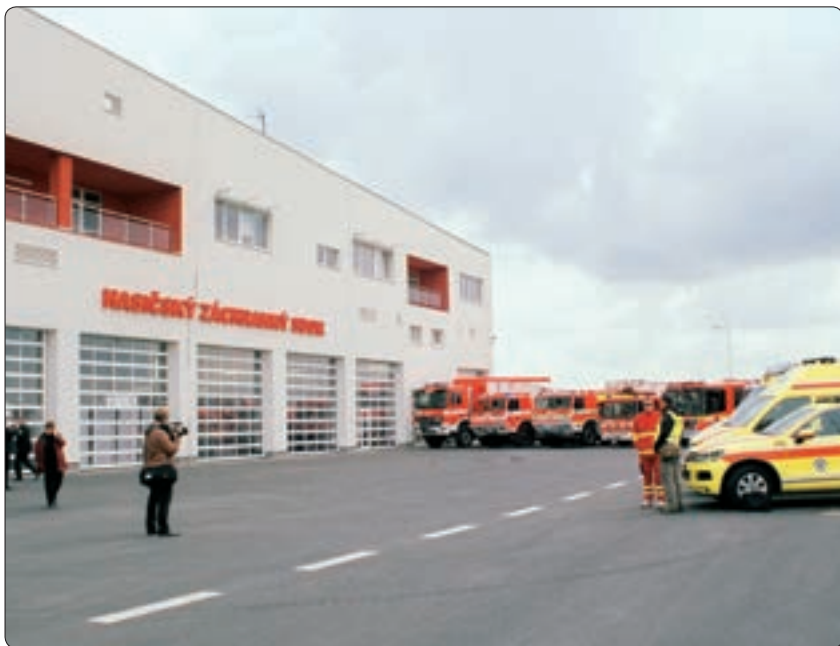
Budova Integrovaného výjezdového centra Ostrava-Jih (25. dubna)
