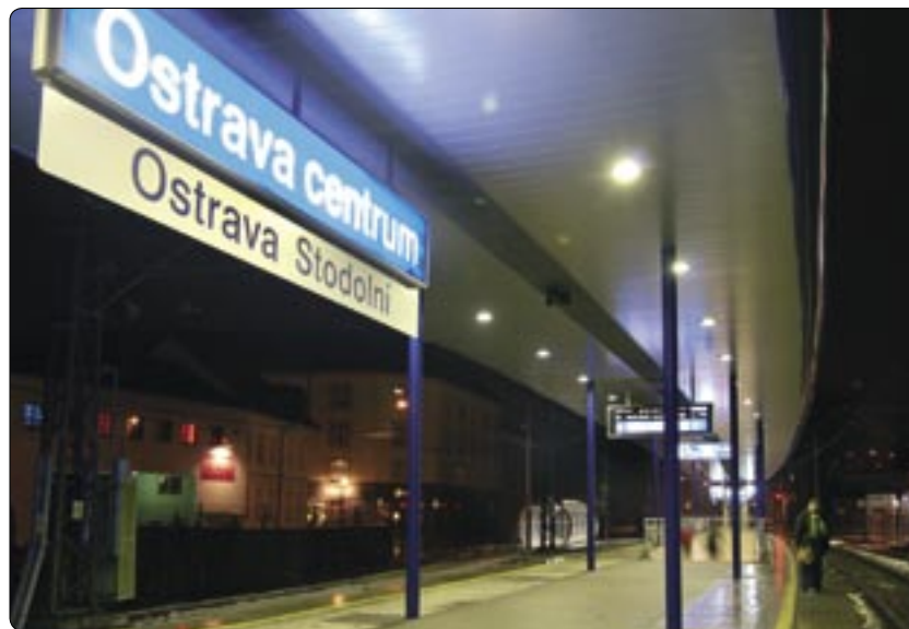
Nová železniční zastávka Ostrava-Centrum (21. listopadu)
