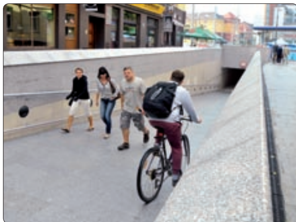
Nový podchod pod Porážkovou ulicí (29. srpna)
