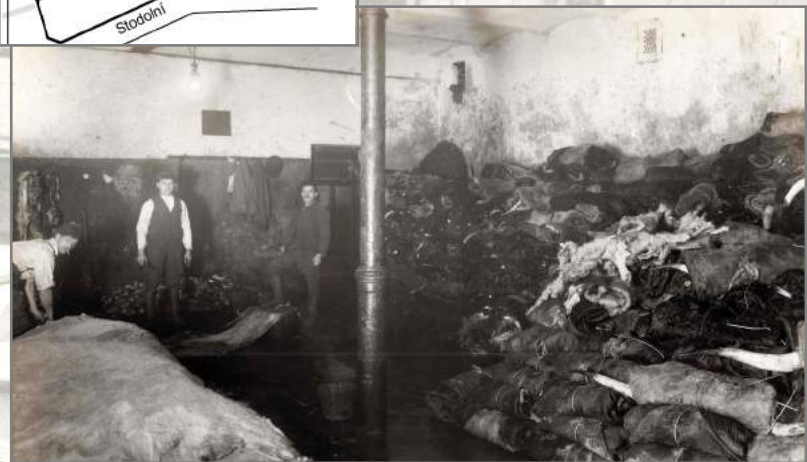
Interiér skladu (podpurný sloup je patrný i na plánu)
