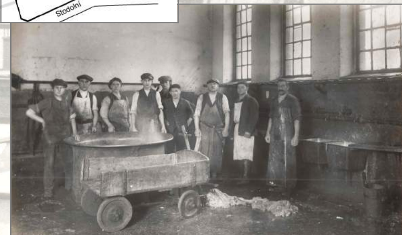
Interiér vepřového oddělení dršťkárny
