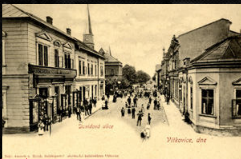
Budova tiskárny Amende & Holaň (vlevo) na dnešní Jeremenkově ulici. Pohlednice vydaná touto tiskárnou, počátek 20. století
