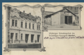
Budova zbrojnice v Přívoze – dnes Hasičské muzeum na ulici Zákřejsové, 1905
