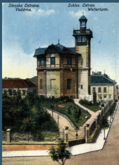
V budově věžového vodolomu s rozhlednou z roku 1909 na Hladnově byla také umístěna hasičská zbrojnice, 1922
