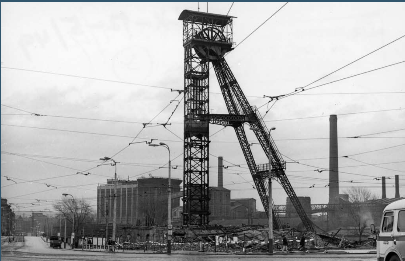
Demolice těžní věže, 28. 11. 1974
