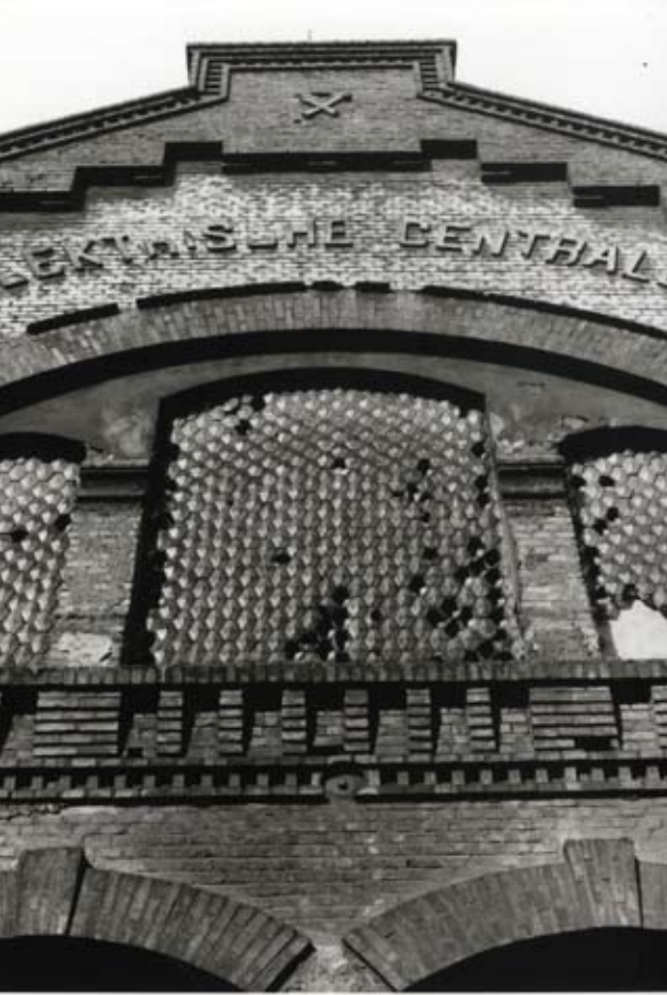
Detail štítu „elektrické centrálky“ postavené v roce 1905 (dnes část trojhal), 80. léta 20. století
