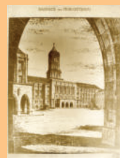
Pohled z nerealizovaného podlaží
