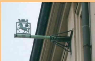
Praporevý stožár na průčelí radnice
