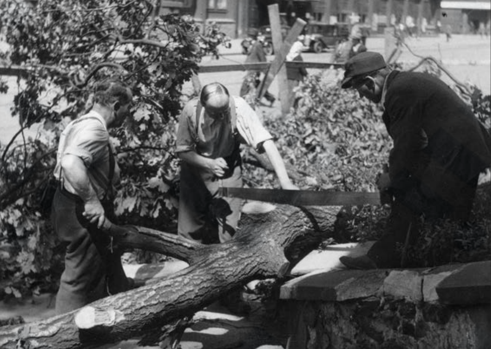
Internovaní němečtí obyvatelé při bourání Německého domu v centru Moravské Ostravy, který byl poškozen při náletech na město v letech 1944 a 1945. Demoliční výměr schválil Národní výbor města Moravské Ostravy už 10. května 1945. Nasazení Němců na odklizec práce mělo symbolicky dovršit jejich pokolení. Na snímku jsou zachyceni při likvidaci německých národních stromů - dubů.
