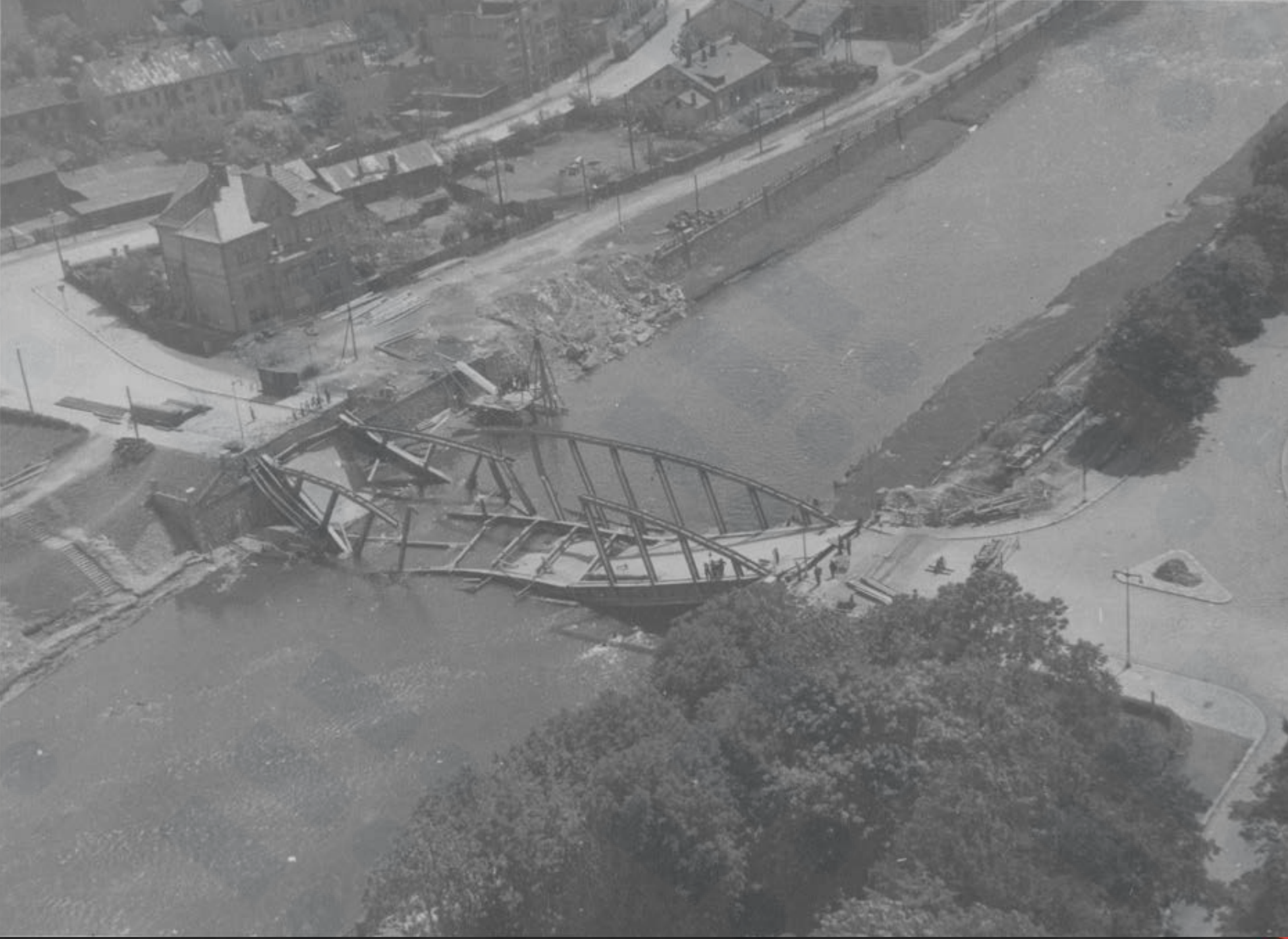
Německá armáda ničila na svém ústupu silniční i železniční mosty přes Odru i Ostravici. Most přes Ostravici u Nové radnice, spojující Moravskou a Slezskou Ostravu, vyhodilo německé vojsko do vzduchu 30. dubna 1945.
