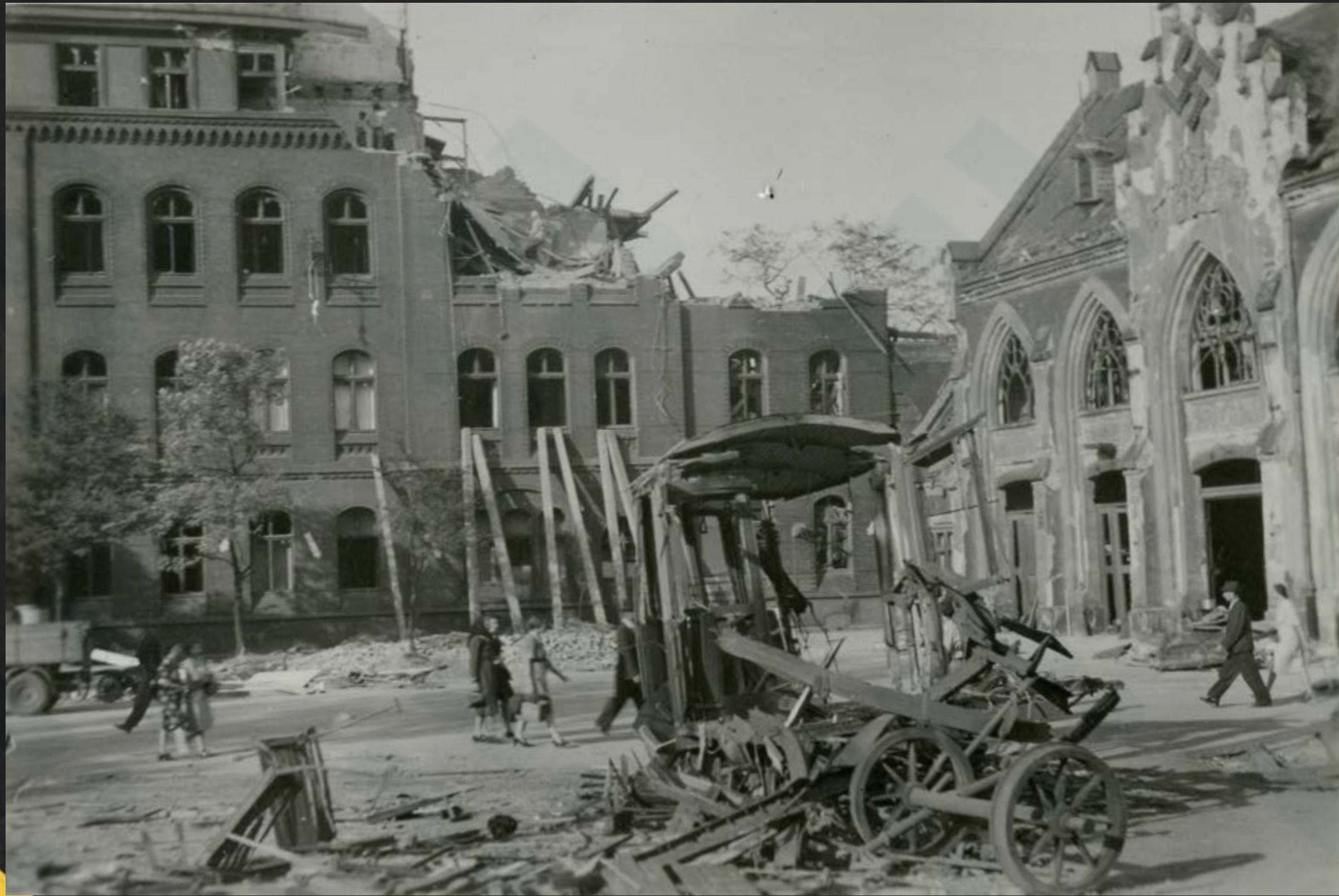
Část dnešního Smetanova náměstí po náletu 29. srpna 1944. Vzadu těžce poškozená budova ředitelství Vítkovických kamenouhelných dolů, vpravo hasičská zbrojnice (po válce zbořena), v popředí zbytky zcela zničeného vagonu tramvaje.
