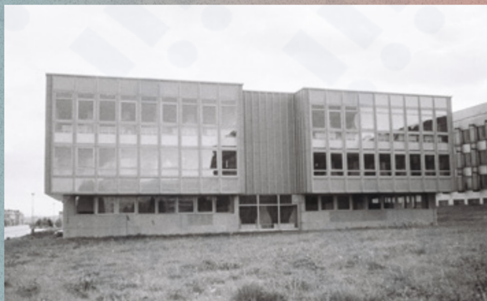
Porubský areál VŠB se na konci 80. let rozrostl o geologický pavilon a novou knihovnu. Tím byla dokončena hlavní část výstavby jednoho z největších vysokoškolských kampusů ve střední Evropě, která probíhala v několika etapách od roku 1965. Pět z celkem sedmi současných fakult VŠB má své sídlo právě zde.
