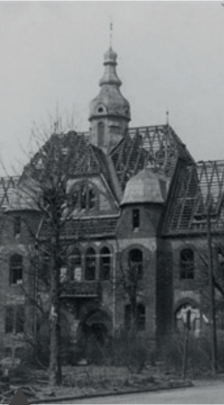
Budova radnice ve Vítkovicích na Mírovém náměstí poškozená osvobozovacími boji
