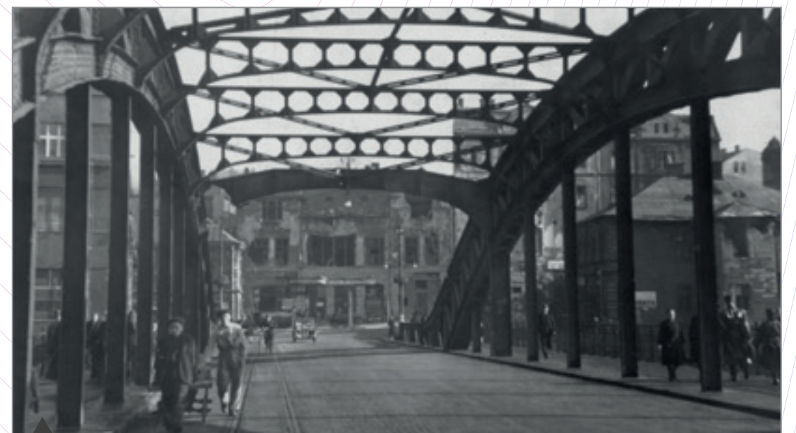
Říšský most (dnes most Miloše Sýkory), který jako jediný nebyl zničen ustupujícími německými jednotkami, pohled z Moravské Ostravy na Slezskou Ostravu (viz bod č. 7 na mapě)
