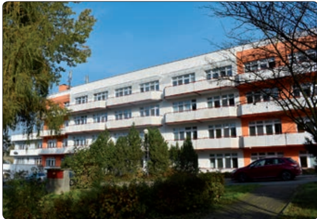
Budova Léčebny dlouhodobě nemocných v Radvanicích po rekonstrukci (31. října)
