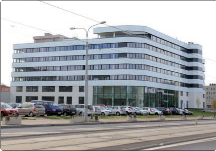
Budova Smart Innovation Center Ostrava (23. května)
