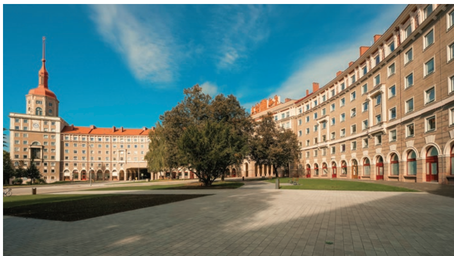
Rekonstruovaný objekt Oblouk v Porubě (8. srpna)
