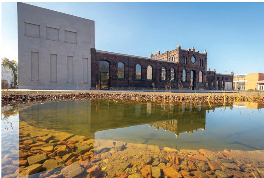
Rekonstruovaná budova moravskoostravských jatek – sídlo galerie PLATO Ostrava (16. května)
