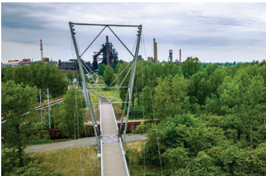
Lávka přes Ostravici navržena architektem Josefem Pleskotem (9. června)
