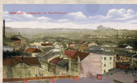
Situace zhruba o 50 let později. Dobová pohlednice zachycující vzhled Nových Vítkovic, kdy se původní centrum zemědělské vesnice odsunulo dále od řeky Ostravice a vytvořilo jádro vznikajícího továrního města. Iniciátorem tohoto plánovitě urbanistického počínu byl generální ředitel Vítkovického horního a hutního těžišťa Paul Kupelwieser.
