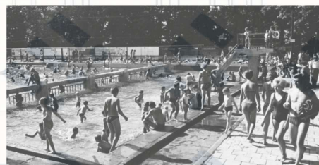
Část hlavního bazénu určená pro děti byla od části pro plavce oddělena pomocí betonové konstrukce původně s fošnovou stěnou. Děti měly vyhrazený prostor o velikosti 10 × 25 m a vlastní skluzavku
