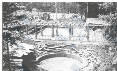
Stavba koupaliště v Hulvákách (1929–1930). Záběr zachycuje budování dětského brouzdaliště o rozměrech 10 × 10 m s dětským koutkem a pískovištěm. Nacházelo se vpravo za hlavní vstupní budovou
