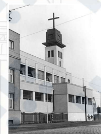
SAKRÁLNÍ STAVBY Mezi stavbami duchovního určení dominovaly v meziválečném období Husovy sbory – mj. ve Vítkovicích (1924), Mariánských Horách (1930), Zábřehu (1933) a Hrabůvce (1934). Největší a vlastně jedinou stavbou římskokatolické církve byl salesiánský kostel sv. Josefa, zvaný Don Bosco. Jednalo se o vůbec první kostel v ČSR s ocelovou konstrukcí, na jehož věži dodnes vyniká šestimetrový nasvícený kříž (Vítkovická ulice, firma Václav Nekvasil, vnitřní výzdoba akademický malíř Jan Obšil, dokončeno 1937)
