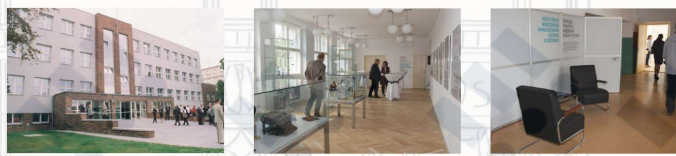
10. září 2015 bylo slavnostně otevřeno nové sídlo ostravského pracoviště Národního památkového ústavu. Památkově chráněný objekt prošel náročnou rekonstrukcí zaměřenou na obnovení původní hodnoty funkcionalistické architektury
