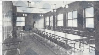
Zasedací sál v nejvyšším podlaží hlavního křídla byl vybaven dřevěným obkladem stěn z mořené dubové dýhy, dubovými parketami a litinovými radiátory
