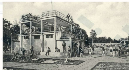
Nejpokrokovějším prvkem ostravského koupaliště bylo spojení filtrační stanice se skokanskou věží, která přiléhala k bazénu ze západní strany. Odvážlivci si mohli skočit do vody ze dvou úrovní – 3,7 m a 6,2 m (30. léta 20. stol.)
