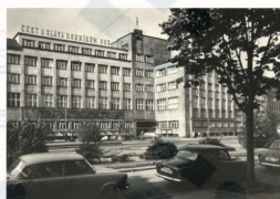
Pohlednice z 60. let 20. století zachycující budovu s příznačným dobovým heslem
