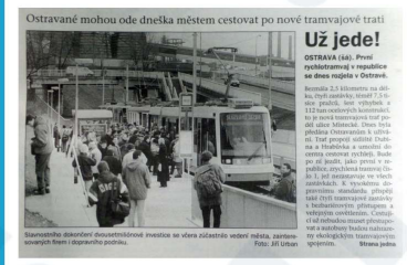
Ostravané mohou ode dneška městem cestovat po nové tramvajové trati. Už jede!
