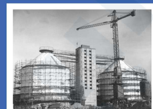
Výrazné zlepšení čistoty vodních toků přineslo zprovoznění ústřední čistírny odpadních vod v Přívoze v roce 1969. Na snímku výstavba vyhnívací nádrže v roce 1967.
