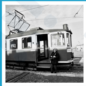
Provoz na intenzivně využívané tramvajové lince č. 1, vedoucí z Ostravy do Hlučína, byl bohužel v roce 1982 ukončen. Původní záměr jejího nahrazení meziměstským trolejbusem nebo vlakotramvají nebyl realizován a spojení dodnes zajišťuje pouze autobus.
