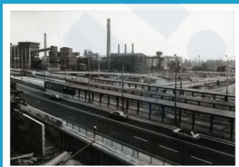
Zastávky na Frýdantských mostech měly být důležitou přestupní stanicí rychlodráhy.
