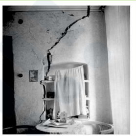
Interiér obytného domu v Přívoze, těžce poškozeného poddolováním, 70. léta 20. století.
