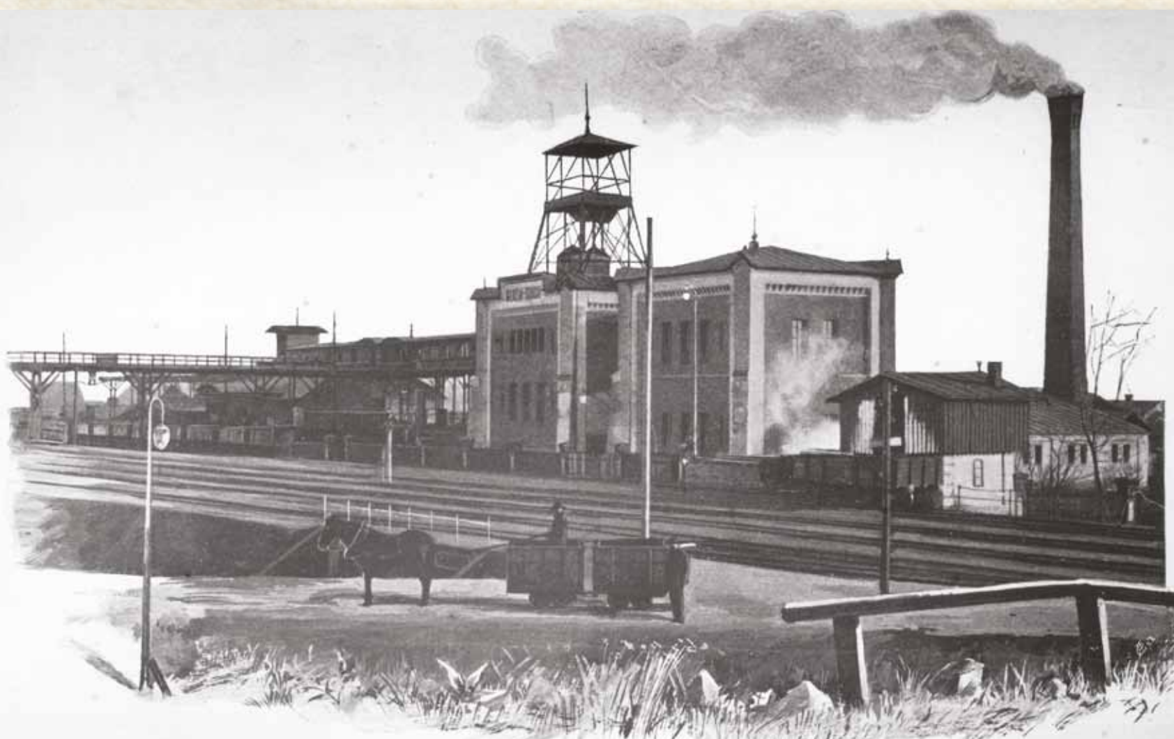
Důl Vilém ve Slezské Ostravě (1859) s pyramidovou těžní věží. Těžba probíhala od r. 1866 do r. 1914, kdy byla těžní jáma rekonstruována na větrné dílo a sloužila pro důl Zárubek. Poblíž jámy Vilém byla vybudována první pokusná štola, kde se testovaly přístroje (plamenné, elektrické) ve výbušném prostředí metanu. Také se zde prováděly pokusy s uhelným prachem, zkoušky důlních lamp, zkoušky výbušnin a další.
