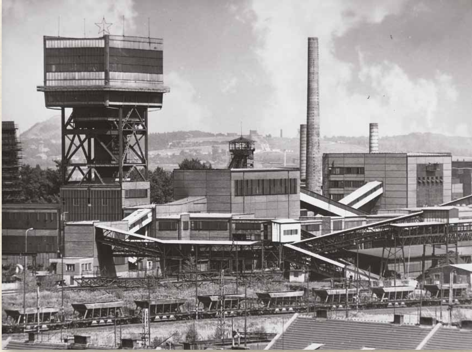
Důl Jeremenko (dříve Louis) ve Vítkovicích (1891) s kladivovou těžní věží z r. 1966 vysokou 53 m s vyhlídkovým ochozem ve výšce 43 m. V pozadí vzpěrová ocelová těžní věž z r. 1892. Od roku 1997 důl zabezpečuje čerpání důlních vod z utlučené části ostravské dílčí pánve. Těžní věž je jediným objektem kladivového tvaru v Ostravě a v r. 2001 byla včetně jámové budovy zapsána do seznamu chráněných kulturních památek.
