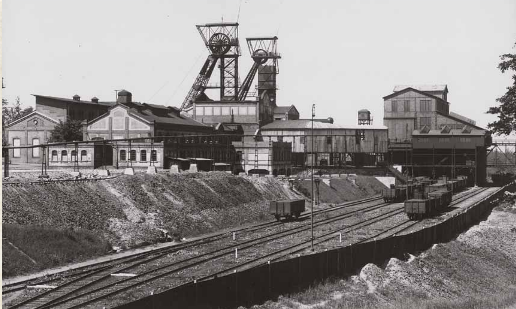
Důl Ludvík v Radvanicích (1898). Důl měl dvě jámy s ocelovými těžními věžemi. Věž č. 1 s výškou 35 m (vpravo) z r. 1909 s věž č. 2 (vlevo) s výškou 46 m z r. 1917. Brzy po začátku hloubení první jámy se narazilo na silný přítok vody a v r. 1901 se kvůli potížím s vodou hloubení zastavilo. Pod vlivem dosti prudkého oživení obchodu s uhlím před první světovou válkou byly práce na hloubení v r. 1909 obnoveny a o pět let později se začalo s těžbou. Těžní věže byly zbourány v r. 1992.
