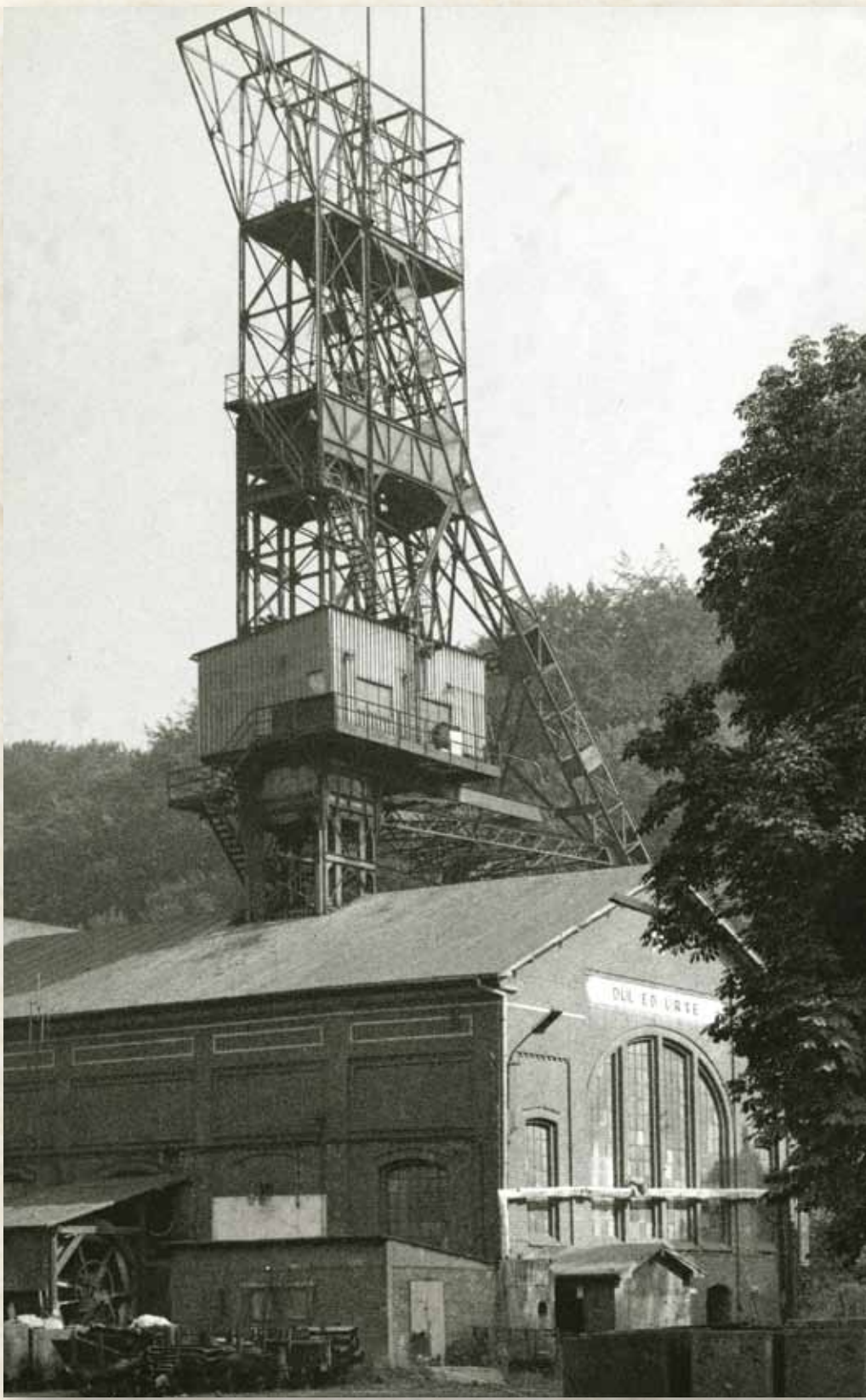
Plán na rekonstrukci těžního zařízení dolu Hlubina v Moravské Ostravě z r. 1891 s novým typem parního stroje a ocelovou těžní věží, která nahradila starší dřevěnou. Důl byl založen v r. 1852. Unikátním řešením byla společná jámová budova pro větrní a těžní jámu se strojovnou, těžním strojem a ventilátorem. V r. 1924 byla těžní jáma přebudována na jámu výdousnou a vyhloubena nová těžní jáma s ocelovou věží, která je dnes jako součást Dolní oblasti Vítkovice kulturní památkou.
