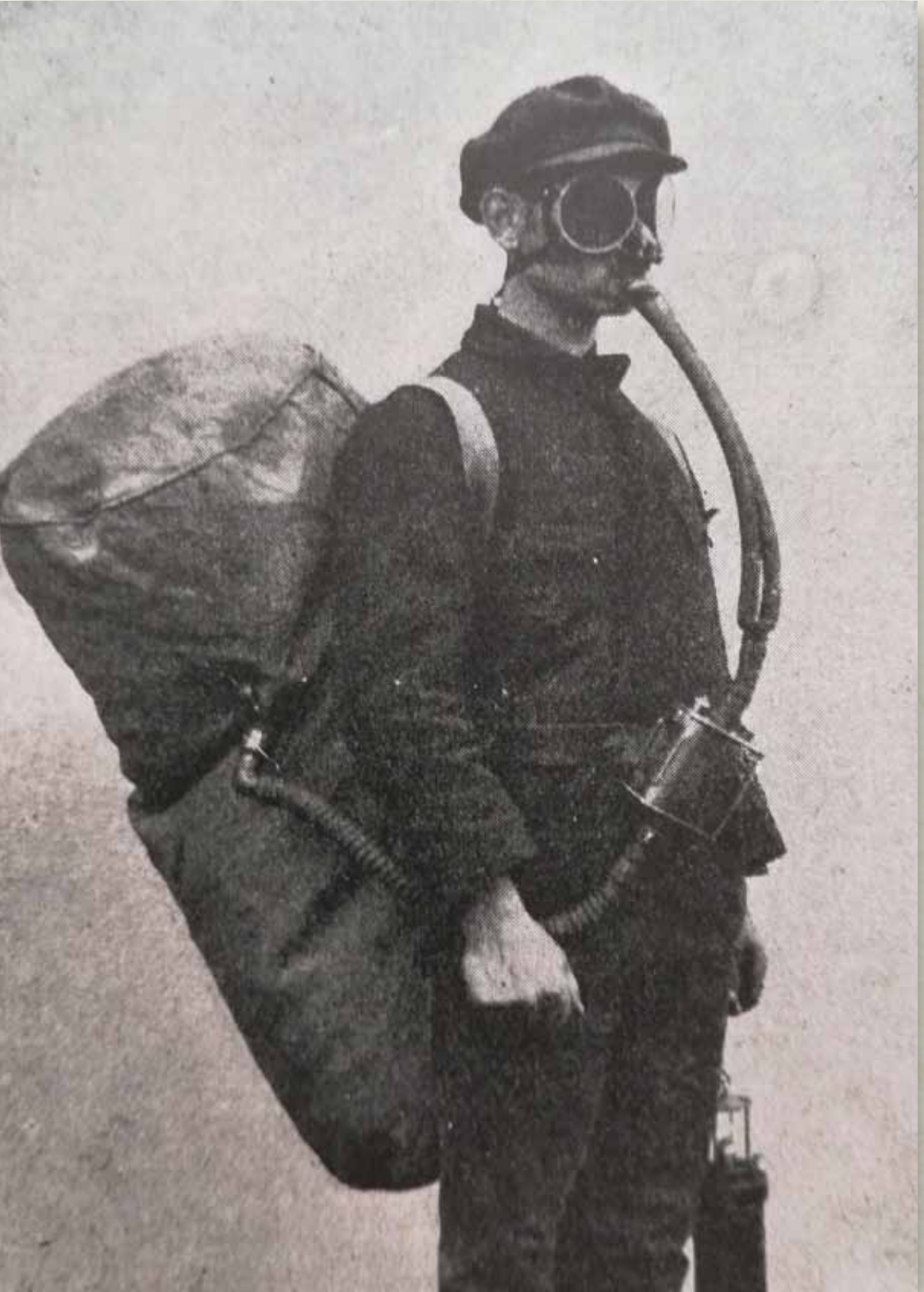
Tzv. Gallibertův měch byl patrně nejstarším na Ostravsku známým záchraným dýchacím přístrojem, užívaným v hornictví. Velký neprodyšný pytel obsahoval zásobu 150l vzduchu, umožňující dýchat jen asi 10 min.
