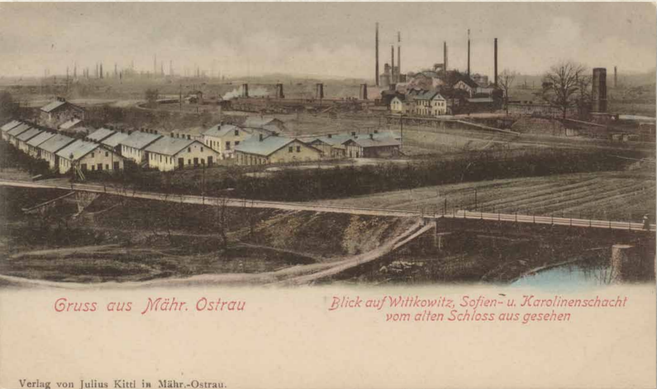
Kolonie Vítkovických kamenouhelných dolů Centrálka ve Slezské Ostravě se nacházela západně od slezskoostravského hradu u soutoku řek Ostravice a Lučiny. V r. 1900 stálo v kolonii 23 obytných budov. Kolonie byla postižena důlními poklesy a častými záplavami a proto musela být v letech 1921–25 téměř polovina domů demolována. Konečná likvidace zbytků kolonie proběhla v souvislosti s povodní v r. 1940.
